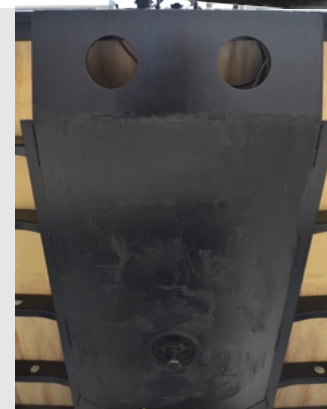
CHAPA DE ATRITO FIXADA NO CHASSI
